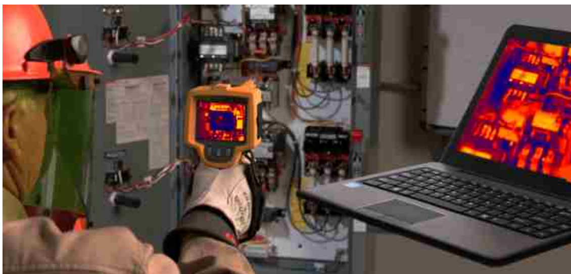
Рисунок 20. Пример проведения тепловизионного контроля электрошкафа
